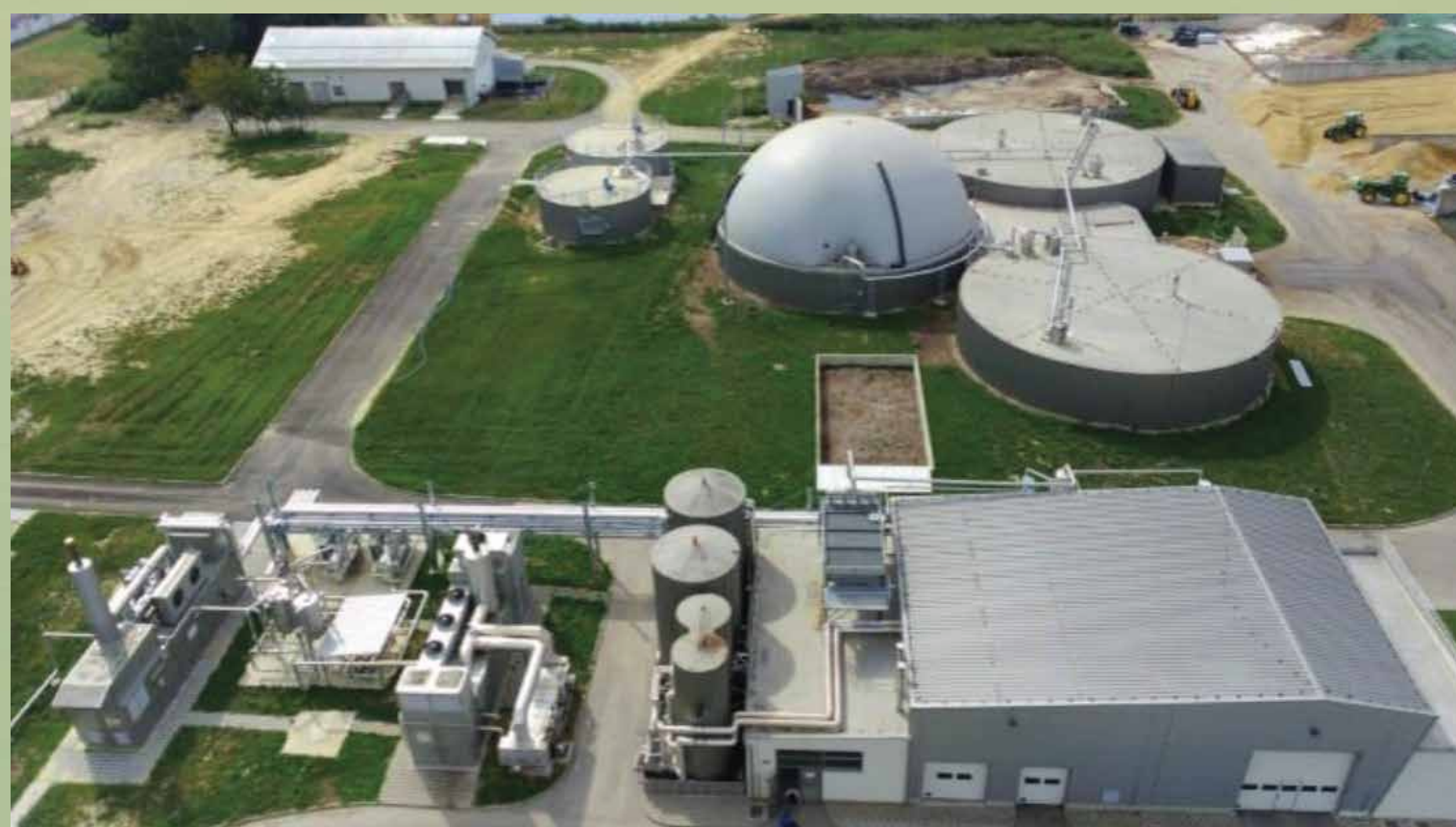
Slika 1: Bioplinsko postrojenje u Gradecu
